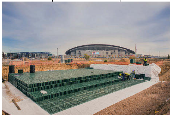
ROJIBLANCO Y SOSTENIBLE. Operarios de Graf instalan un sistema de drenaje frente al estadio del Atlético de Madrid.
